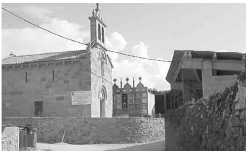
Frente à fachada da igreja românica de Leís, José Bello Bello levantou um galpão (à direita na fotografia) coroado por um tecto de uralita que supera em mais de um metro o muro que linda com o caminho que separa a obra da igreja.
