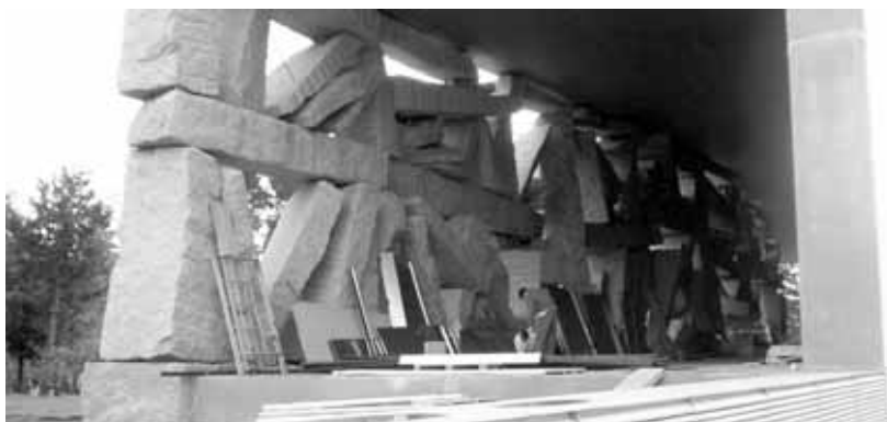
Estado das obras na futura sede da SGAE em Compostela, na rua das Salvadas
