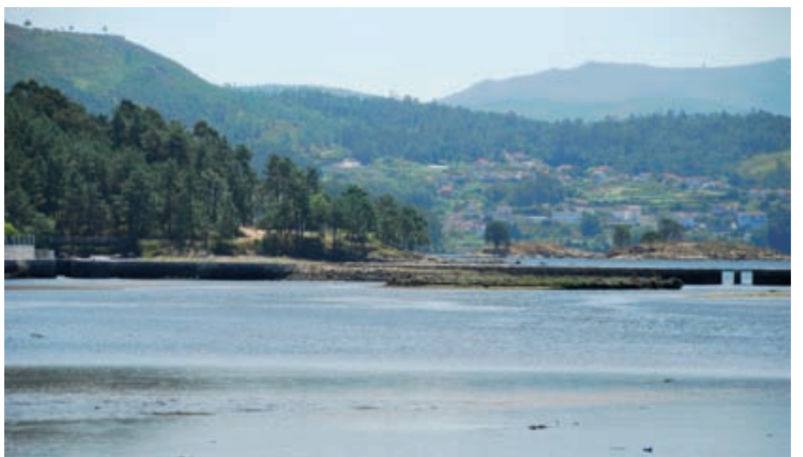
Dique restaurado. Na zona da esquerda do dique havia um moinho de marés
